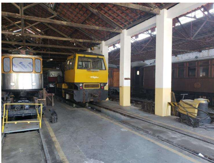
Figura 103: Valas de manutenção e estacionamento britado - Pátio Pindamonhangaba
